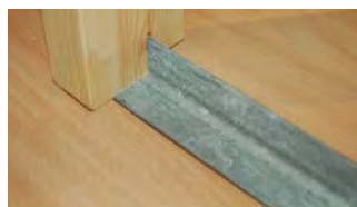
L-järnströskel VFZ 30x30x3 mm
